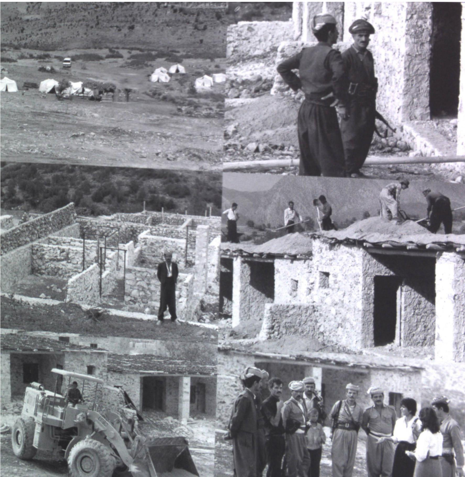
Reconstruction des villages kurdes du nord de l'Irak. Source : 619.4.IRQ
